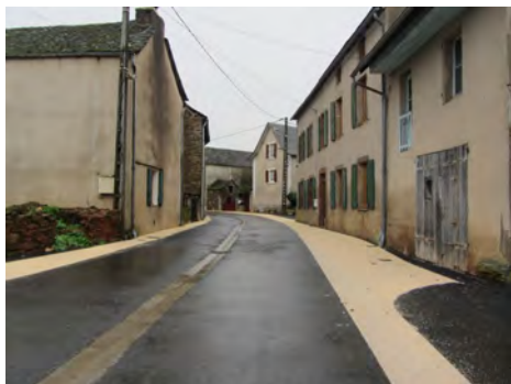
Les travaux de la rue de la Cambonne .
