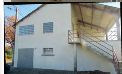
Les vestiaires du stades rénovés.
